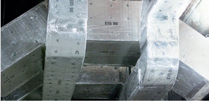
1. Conlit Ductrock 90 für eckige Lüftungsleitungen, abP P-3335/4305-MPA BS
