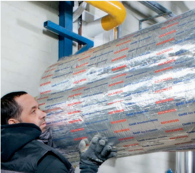
Alle Schnittstellen und Stöße sind mit Aluminiumklebeband, ROCKWOOL Alufix, zu verkleben
